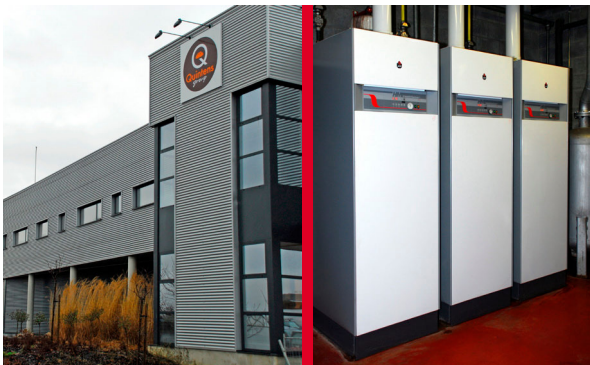
HeatMaster® TC cascade-opstelling bij Q-Bakeries (Diest)
