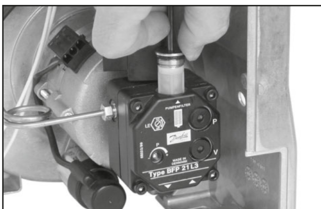
Afbeelding 25 — Oliefilter uithalen
