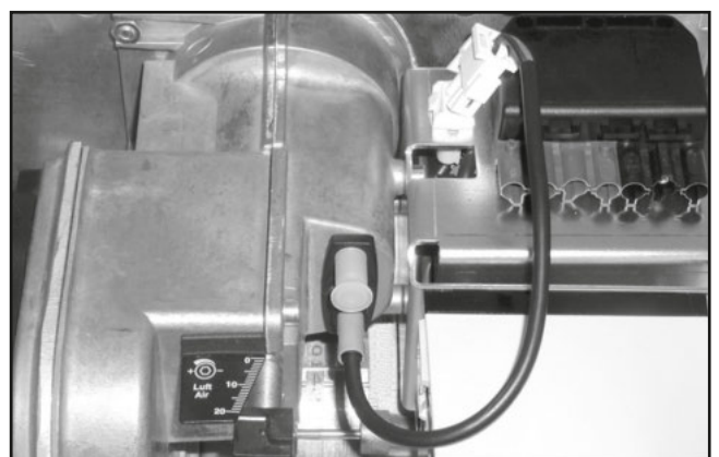
Afbeelding 29 — Stekkeraansluiting voor vlamcontrole cel
