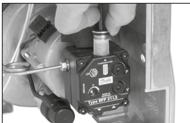
Figure 25 — Démontage du filtre à fioul
