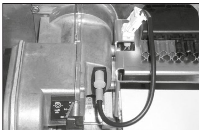
Figura 29 — Conexión de la clavija de la fotocélula
