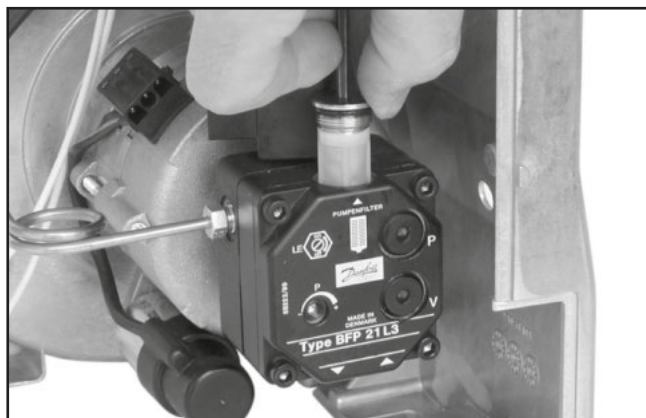
Figure 25 — Démontage du filtre à fioul
