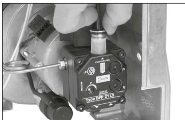
Figura 25 — Desmontaje del filtro de gasóleo
