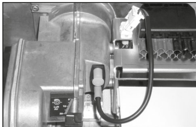
Afbeelding 29 — Stekkeraansluiting voor vlamcontrole cel
