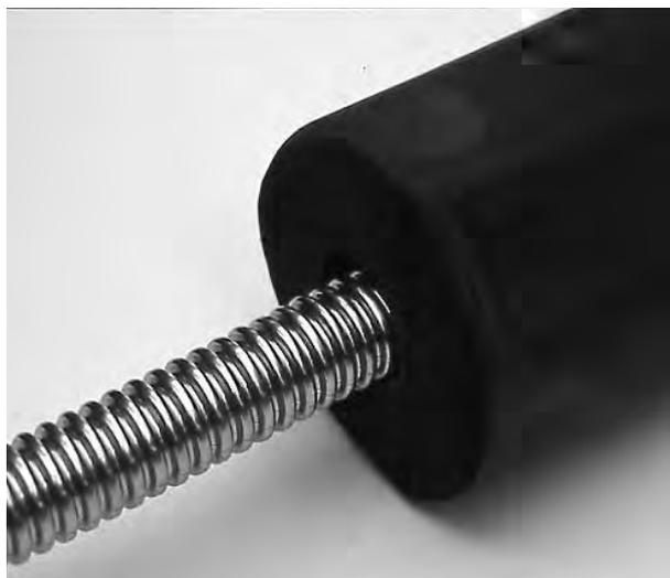
Fig 9 Veillez à bien recouvrir l'ensemble du flexible avec l'isolation et de refermer avec une bande de réparation.
