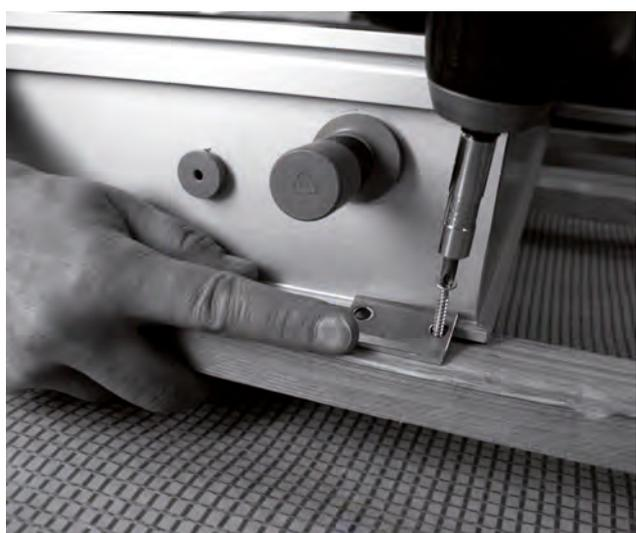
Figure 16 Vissez sur la latte D, la cornière supérieure des capteurs, à droite et à gauche, au moyen de 2 vis.
