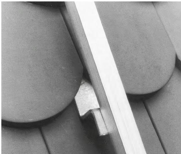
Fig. 7 Patte de fixation pour tuile plate
