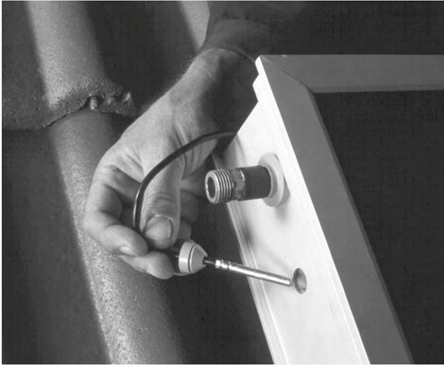
Fig. 25 Retirez le bouchon du doigt de gant et glissez-le sur la sonde. **Soyez certain de bien insérer la sonde dans le doigt de gant du capteur et refermez.** Passez le câble par la tuile chatière et raccordez-le sur le boîtier de protection de surtension! Attention au positionnement de la sonde sur le départ (chaud) du capteur !
