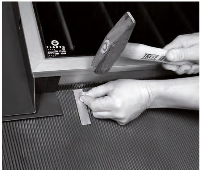
Figure 26 Fixez le plus haut possible sur la jupe d'aluminium plissé 3 languettes en tôle par capteur, côté peint vers le bas.
