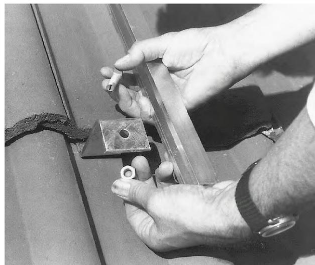
Fig. 4 Le raccordement sûr par profilé de montage, vis à tête marteau et patte de fixation (ici: pour tuiles mécaniques)
