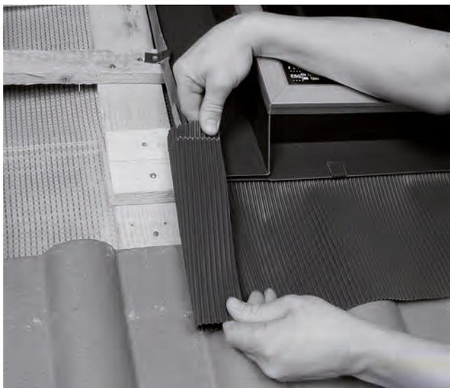
Figure 29 Repliez la jupe d'aluminium plissé autour du profilé de recouvrement inférieur.
