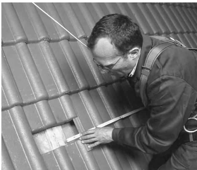
Fig. 16 Mesurez le champ d'implantation prévu pour les capteurs sur le toit et découpez en dégagant les tuiles les points de fixation sur les chevrons.
