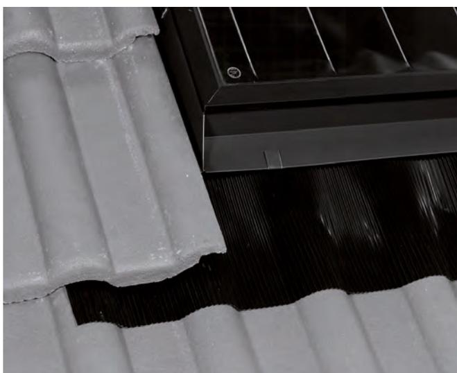
Figure 39 Retirez les bandes de protections adhésives et appuyez la jupe d'aluminium solidement contre les tuiles.
