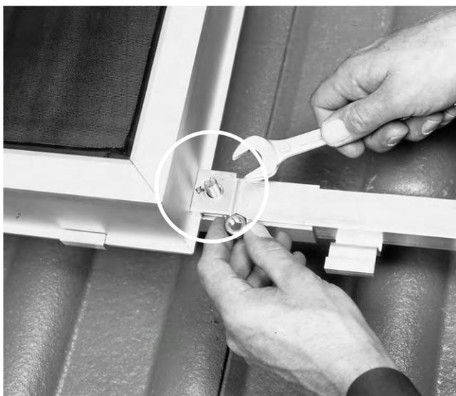
Fig. 23 Pour montage vertical des capteurs: fixez les ensuite avec les brides de façon que la flèche pointe vers le capteur. Puis insérez le capteur suivant.
