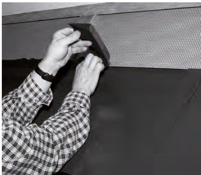
Figure 36 Sur le profilé de recouvrement supérieur, le long du pli, collez une bande de mousse en caoutchouc.
