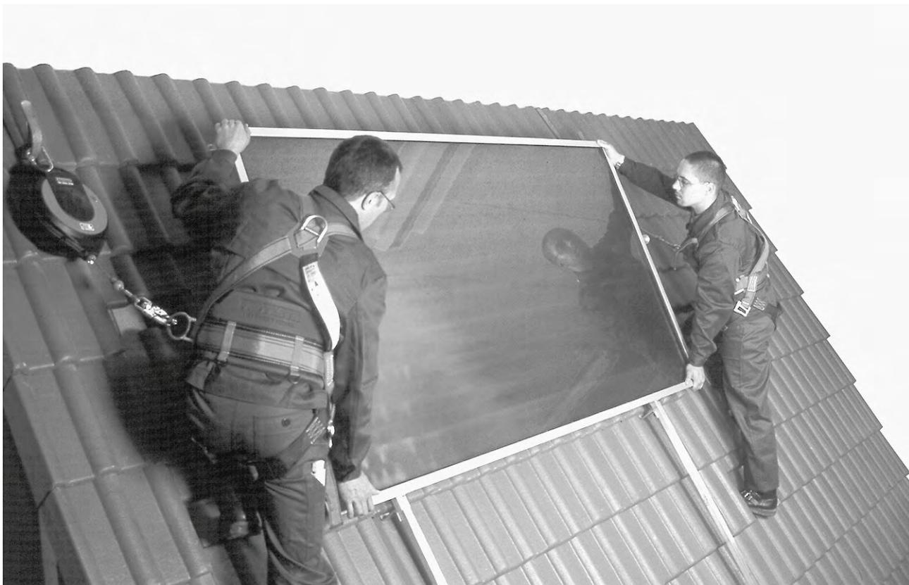
Fig. 1 Le système peut facilement se poser à deux sur toiture sans découverte et sans soudure.
