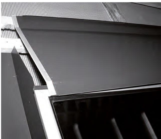
Figure 31 Placez les bandes de rives laterals dans les rainures hautes à droite et gauche des capteurs. Puis insérez la cannelure de tôle dans la fente du capteur comme indiqué.
