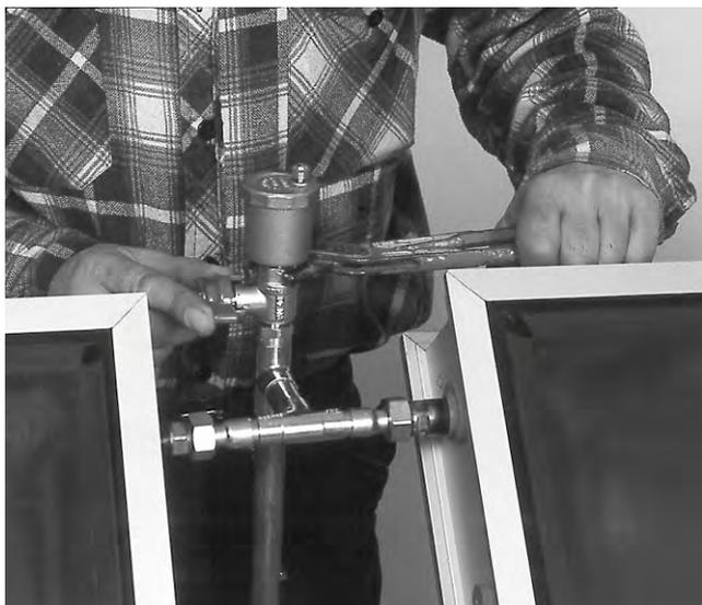
Fig. 17 Raccordez les capteurs avec le circuit solaire au moyen des raccords à souder 1/2"-18. N'oubliez pas les joints haute température.
