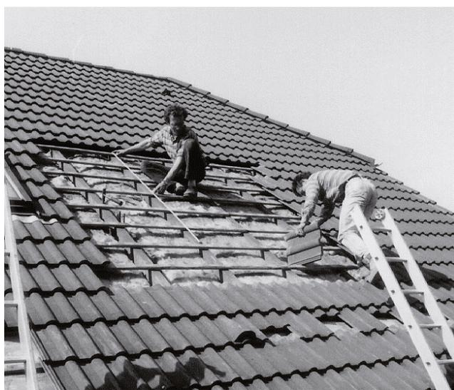
Figure 10 Définition du champ d'implantation des capteurs, relevé des cotes avec la règle de mesure et découverture des tuiles.
