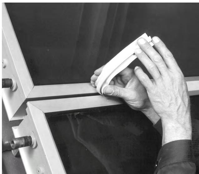
Fig. 24 Insérez le profilé T en silicone dans l'interstice entre deux capteurs
