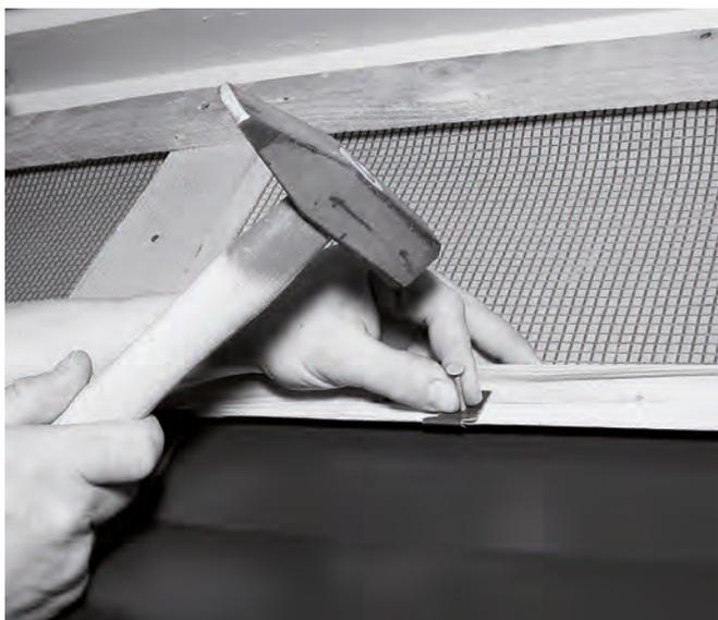
Figure 35 Le profilé de recouvrement supérieur doit être fixé à l'aide de 2 clous sur la latte de toiture.
