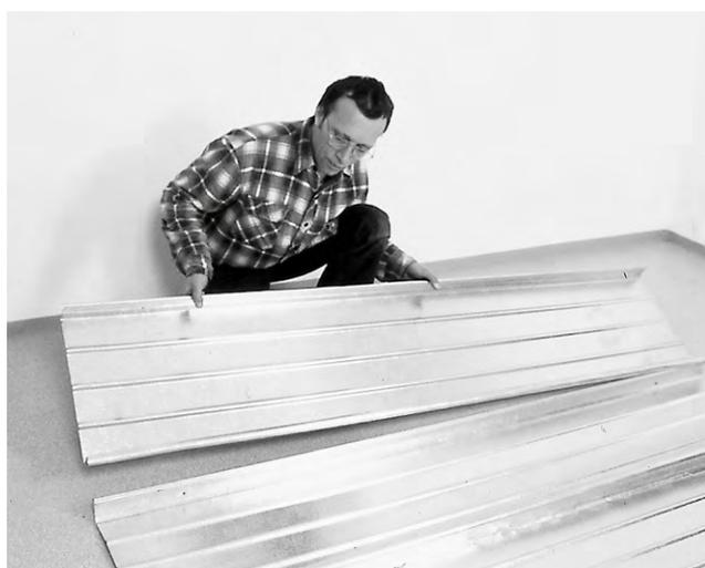
Fig. 10 Posez les profils Alu pour la fixation au sol – alternativement posez les supports en béton – (cf. Tab.2 pour le nombre). Si vous fixez les profils Alu, utilisez vis et chevilles.
