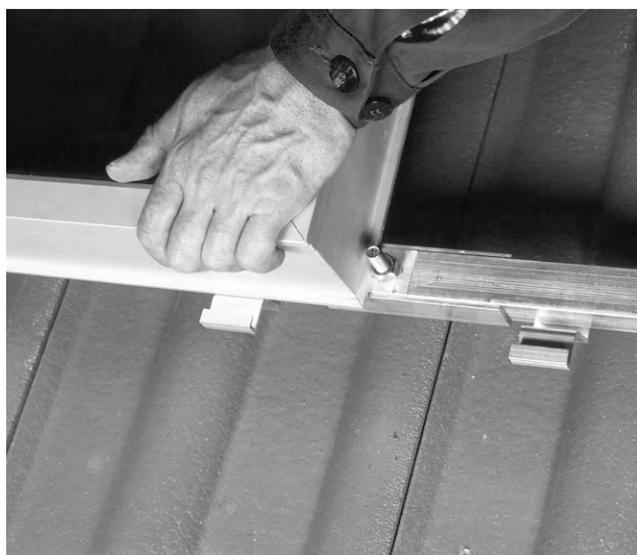
Fig. 22 Pour montage vertical des capteurs: insérez les d'abord dans les clips de retenue
