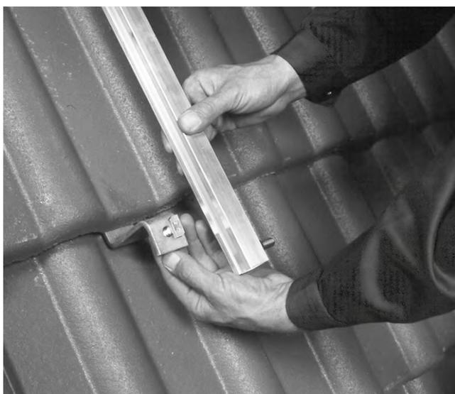
Fig. 18 Ajustez les profilés de montage à la même hauteur et fixez-les sur les pattes de fixation de façon à ce que la tête marteau après serrage soit en position transversale à l'intérieur du profilé
