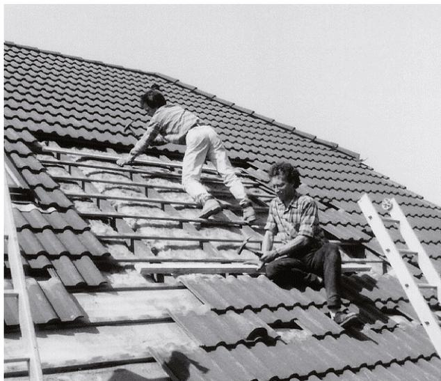
Figure 11 Marquez à l'aide de la règle (cf. Fig. 4) l'emplacement des lattes et fixez-les avec des clous de type 65. Vissez les lattes B.
