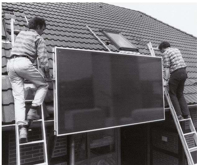
Figure 13 Pour la pose des capteurs, lors des travaux sur toiture et dans votre intérêt, veuillez suivre les consignes de sécurité.
