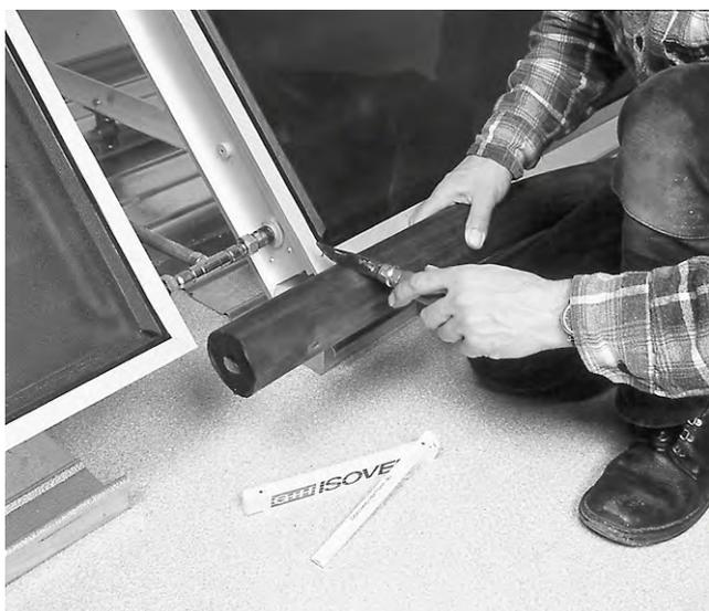
Fig. 19 Après vérification sous pression de l'étanchéité des raccords, isolez les tuyaux avec un isolant thermique résistant aux UV.
