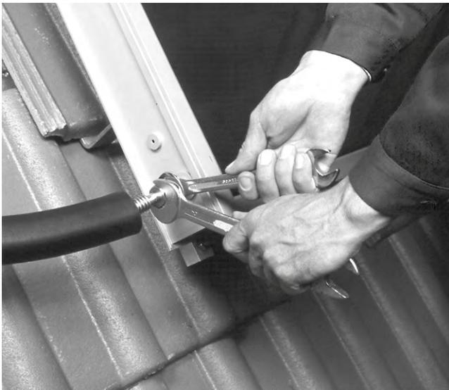
Fig. 27 Le contre serrage protège le raccord du capteur contre tous dommages. Prenez soin de faire passer les flexibles dans le toit en remontant vers le haut.
