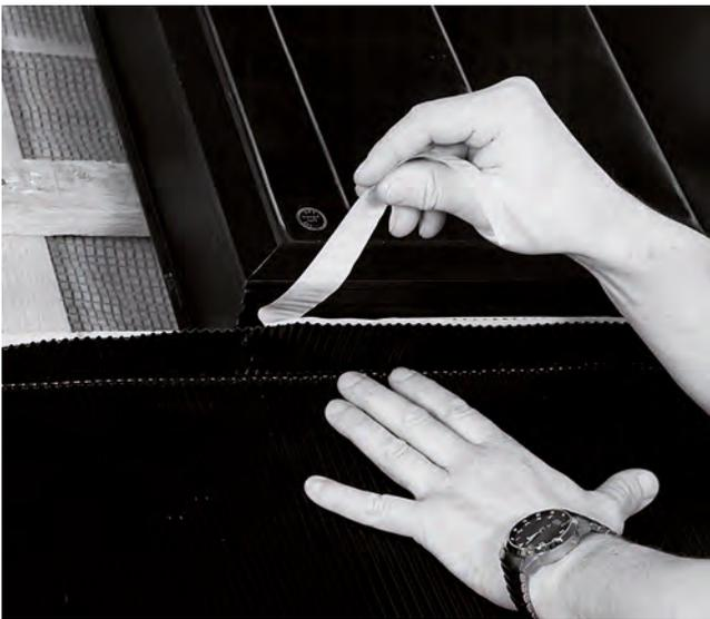
Figure 23 Ajustez la bordure pliée de la jupe d'aluminium contre le bord inférieur du capteur, retirez la bande de protection adhésive supérieure et fixez le profilé le plus près possible de la bordure, afin de ne laisser dépasser environ que 15 cm de chaque côté du capteur.
