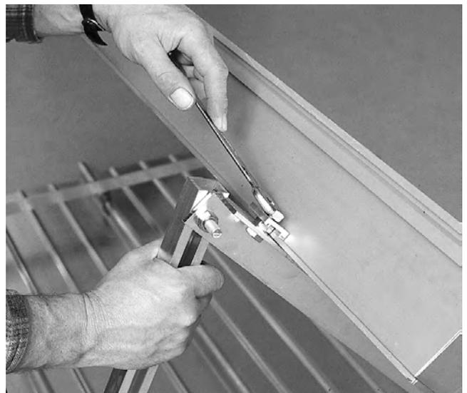
Fig. 16 Fixez le capteur HelioPlan N avec les pinces d'ancrage après le profilé (pièce 1, Fig. 2,3 ou 4), les flèches sur les pinces d'ancrage doivent pointer vers les capteurs (voir agrandissement Fig. 2)
