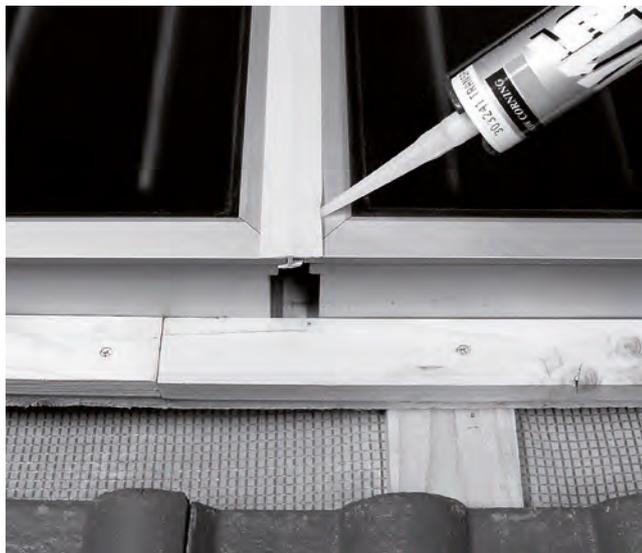
Figure 17 Pour compléter l'étanchéité de l'ensemble de l'installation, appliquez une fine couche de silicone entre les ailes du profilé T et le cadre du capteur.
