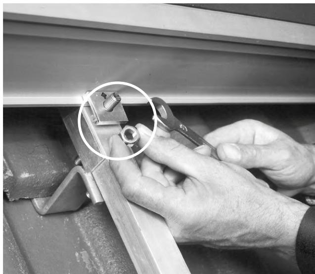
Fig. 20 À l'aide des brides de fixation, fixez les bords hauts et bas du capteur sur les profilés de montage de façon que les flèches gravées sur les brides de fixation pointent vers le capteur
