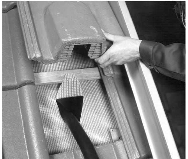
Fig. 28 Pratiquez une ouverture dans le film d'étanchéité et placez la tuile chatière. Raccordez les flexibles au circuit solaire et, tirez les liaisons isolées jusqu'au capteur
