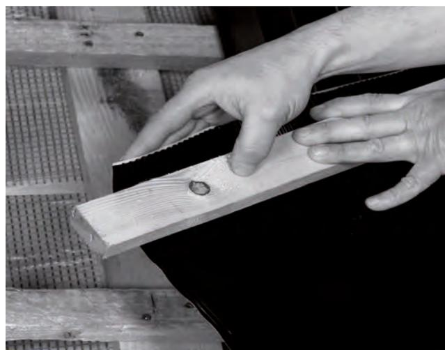
Figure 22 Pliez la jupe plissée en aluminium fournie avec un angle de 90° au moyen d'une latte.
