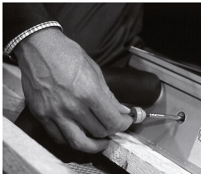
Figure 20 Retirez le bouchon du doigt de gant de la sonde situé le plus près de la sortie du fluide caloporteur des capteurs. Percez ce bouchon au moyen de la sonde. Introduisez la sonde dans le doigt de gant et refermez le capteur avec le bouchon. Passez ensuite le câble dans le toit.
