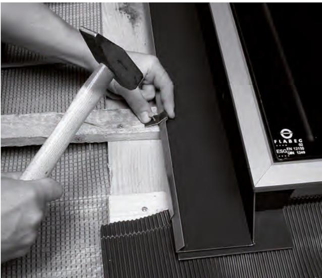
Figure 25 Emboîter les bandes de rives latérales dans la rainure supérieure des capteurs et les glisser le plus possible vers le bas, puis clouer les fixations sur les liteaux de bois.
