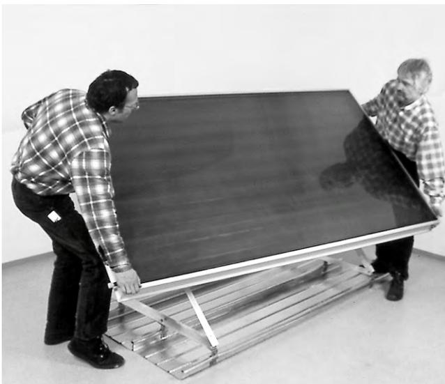
Fig. 15 Placez le capteur de façon à ce qu'il se cale entre les écrous supérieurs et inférieurs du profilé.
