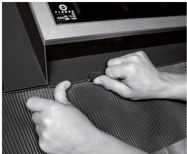
Figure 28 Fixez le profilé de recouvrement inférieur en repliant vers le haut les 3 languettes en tôle précédemment fixées.
