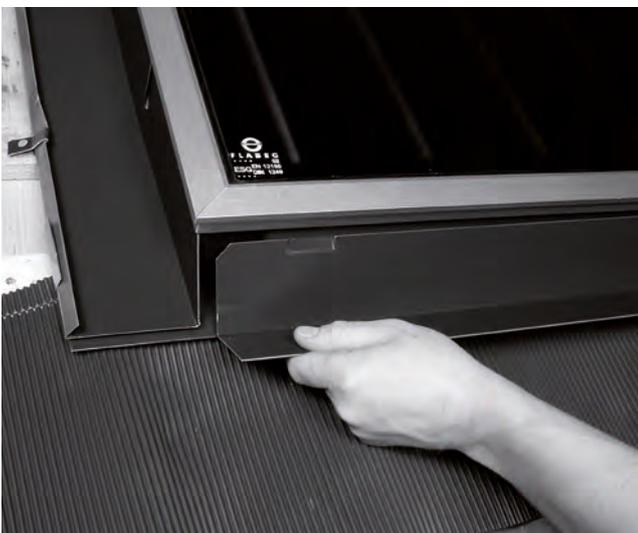
Figure 27 Enfilez le profilé de recouvrement inférieur le plus long dans la cornière basse du capteur de gauche.
