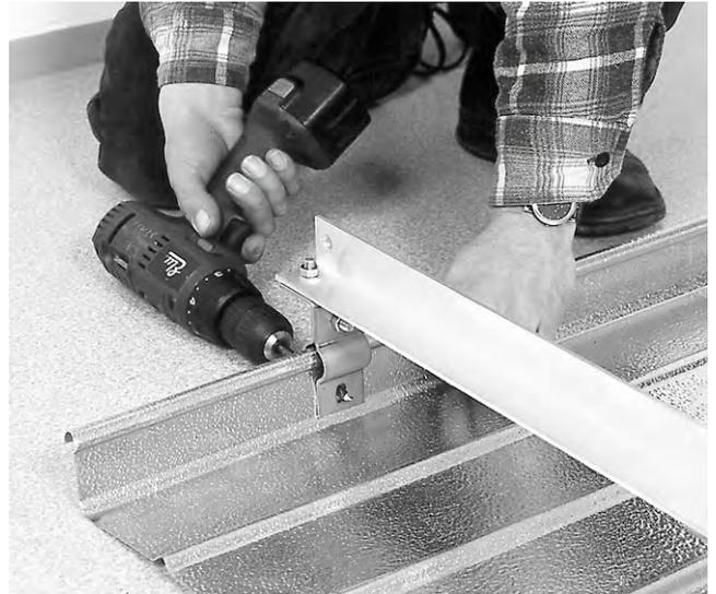
Fig. 12 Pour attacher la partie inférieure du cavalier, percez un trou à travers l'orifice inférieur du cavalier et la tôle en Alu. Vissez comme indiqué le profilé, la tôle et le cavalier.
