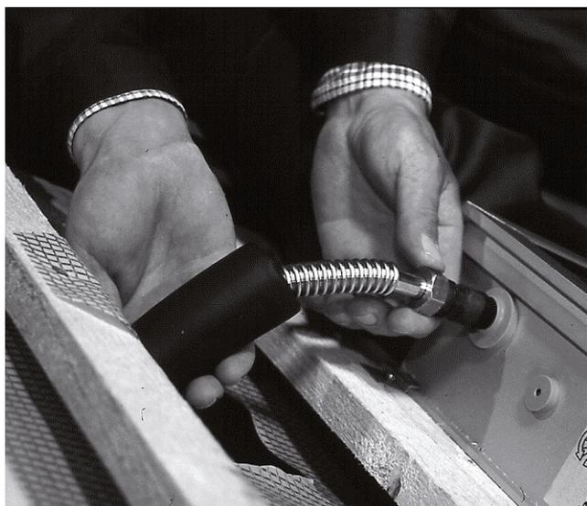
Figure 19 Vissez les flexibles inox aux raccords restés libres des capteurs et connectez-les avec les canalisations (1/2"-18mm de raccords) de l'installation solaire. Repoussez les canalisations vers le bas, pour faciliter par la suite le recouvrement du toit.
