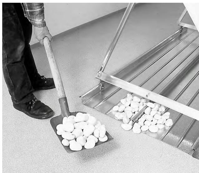
Fig. 20 Pour terminer, recouvrez le profil aluminium d'une couche de gravier (Hauteur, cf. Fig.6 page 4).
