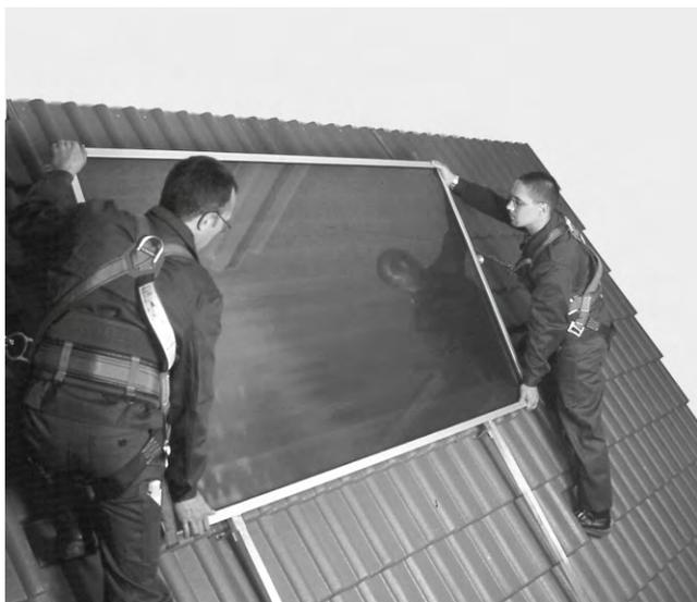
Fig. 19 Positionnez le capteur sur les profilés de montage afin que le coté inférieur repose sur les boulons.
