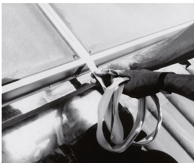
Figure 15 Insérez le profilé T en silicone dans la fente entre les deux capteurs. Pour faciliter l'opération, tirez et poussez alternativement sur le profilé. Terminez l'opération en rapprochant les deux capteurs. Coupez l'excédent du profilé T.
