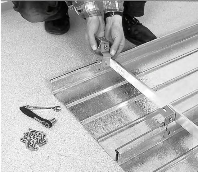
Fig. 11 Posez 2 profilés cornière en aluminium (pièce 2 Fig. 2,3 ou 4) par capteur sur les profils de tôle Alu (marge de 5 à 10 cm à partir du côté du cadre du capteur). Ajustez et attachez le cavalier par rapport à ces côtes et vissez la partie supérieure, comme indiqué.
