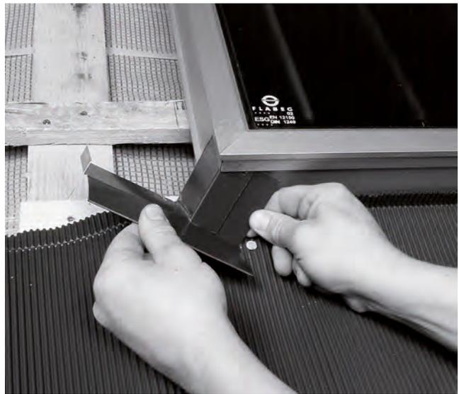
Figure 24 Insérez les cornières des bandes de rives latérales dans la rainure la plus basse du capteur et les appuyer contre les encoignures du capteur. A la base, la bande de rive se fixe au-dessus de la jupe de plomb plissée.
