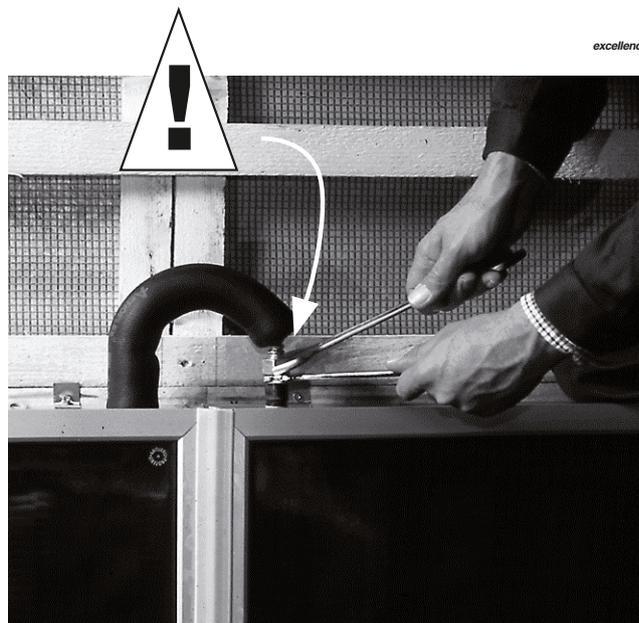
Figure 18 Raccordez les capteurs avec le flexible en inox fourni. Prenez soin de bien mettre les joints d'étanchéité et lors du serrage, utilisez une seconde clé de contre serrage pour éviter d'endommager les raccords des capteurs. Clés 19 et 24.
