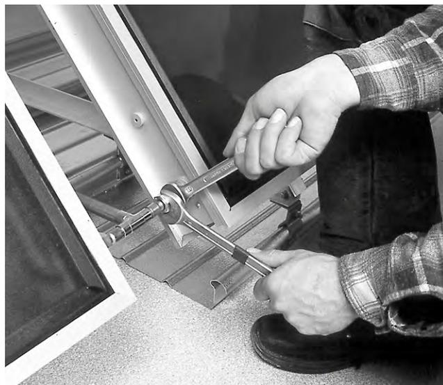
Fig. 18 Lors du serrage utilisez une seconde clé de contre serrage pour éviter d'endommager les raccords des capteurs. Remarque vérifiez la position de la sonde sur le départ (chaud) du capteur ! (Clé de 19 & 24)
