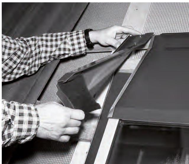
Figure 32 Collez un morceau de mousse en caoutchouc expansé noir de 11 cm sur le closoir latéral supérieur. Puis fixez-le sur la latte supérieure. Ensuite, emboîtez-le sur le côté du capteur le long de la rainure et tirez-le vers l'extérieur pour un étanchement latéral.
