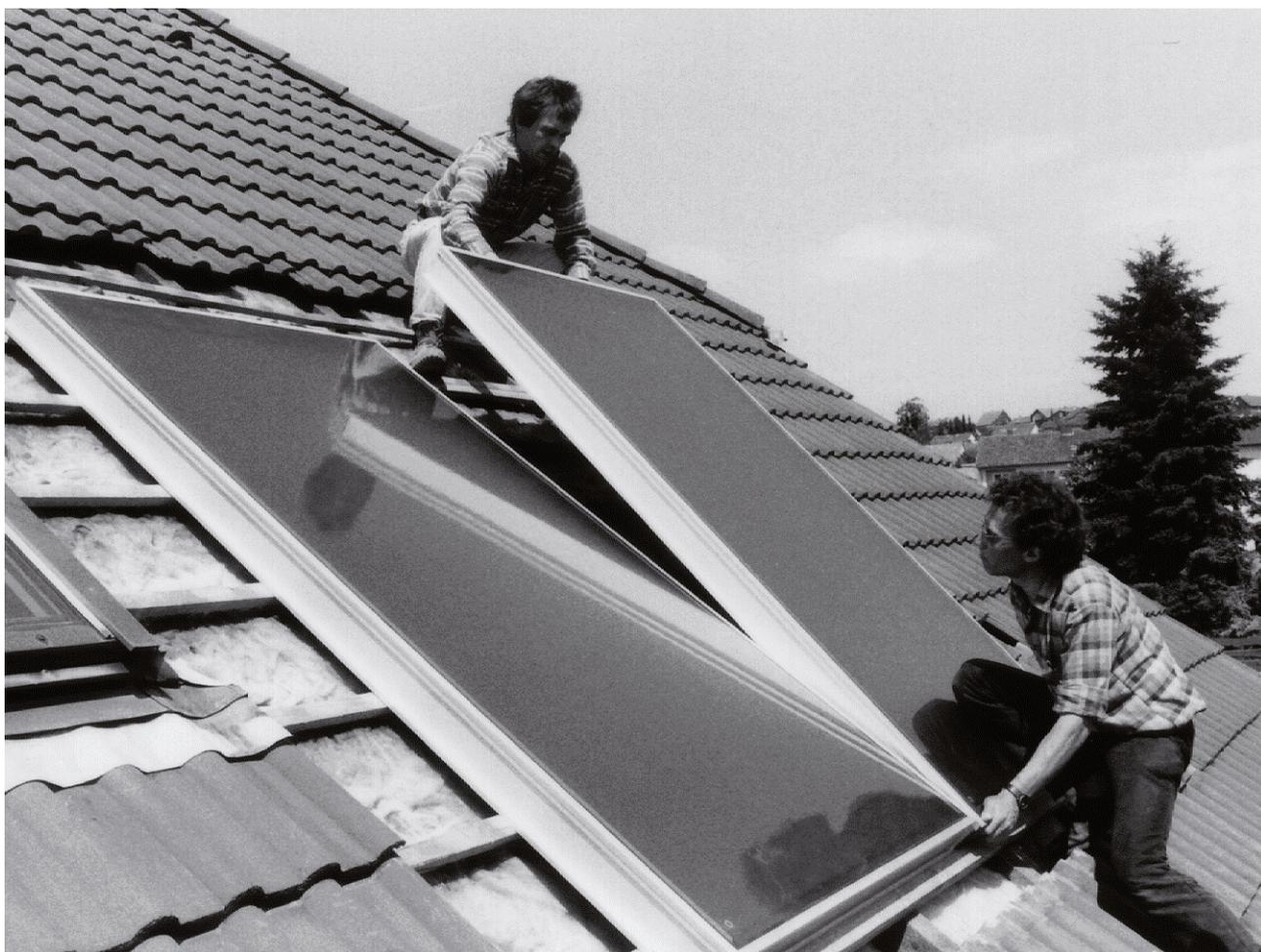
*Figure 1 Le capteur ACV avec son système d'intégration en toiture se laisse facilement installer à deux et s'intègre parfaitement dans la couverture de la maison.*
