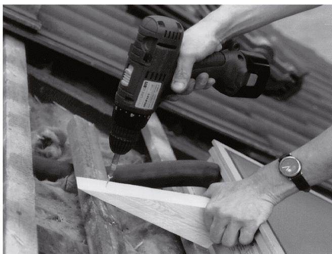
Figure 21 Posez le profilé en bois au dessus du capteur et fixez-le avec des vis taraudeuses de construction.
