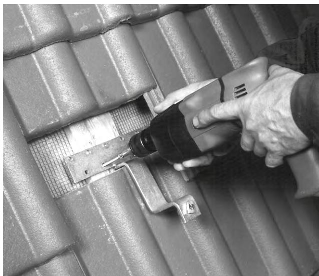
Fig. 17 Fixez la patte de fixation à l'aide des vis à bois (6x80) sur le chevron. Si l'épaisseur de la volige dépasse 30 mm, rehaussez la patte de fixation en conséquence. Replacer ensuite la tuile à sa place en modifiant au besoin le dessous de celle-ci pour qu'elle tombe à plat.
