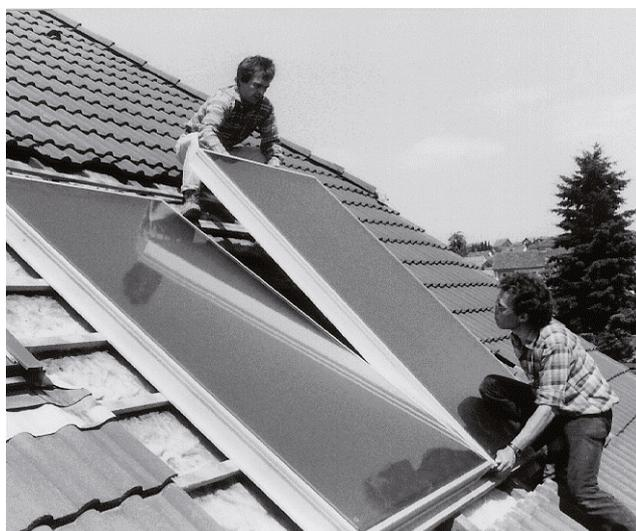
Figure 14 Posez les capteurs dans l'espace découvert par rapport à aux lattes B. Laissez un espace uniforme de environ 8mm entre les capteurs –pour la fixation du profilé T en silicone– et si besoin réajustez une latte B.
