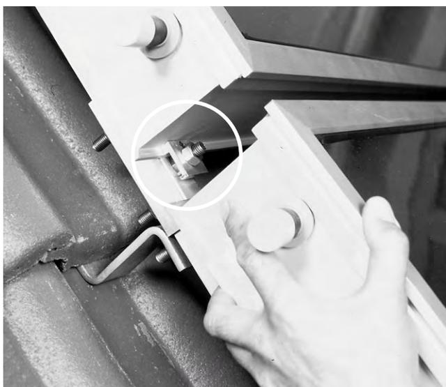
Fig. 21 Glissez le bord supérieur du capteur inférieur sous la bride de fixation et vissez les brides de fixation inférieures de façon que la flèche pointe vers le capteur.
