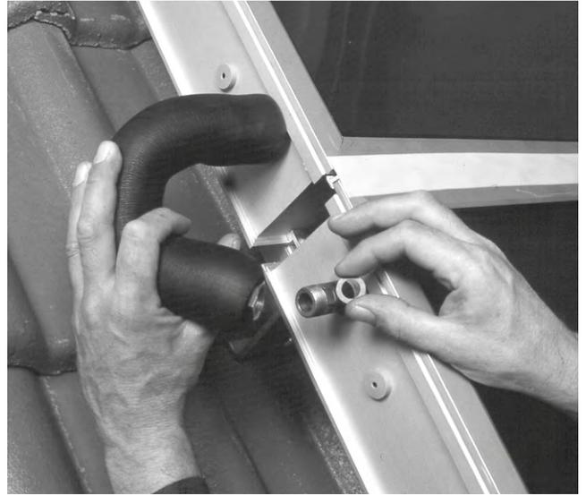
Fig. 26 Raccordez les capteurs avec les flexibles inox. Prenez bien soin de ne pas oublier les joints plats haute température d'étanchéité.
