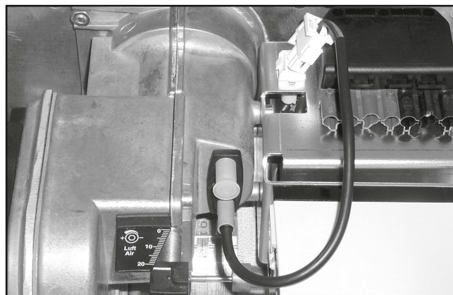
Figure 29 — Prise de raccordement de la cellule photo-électrique
